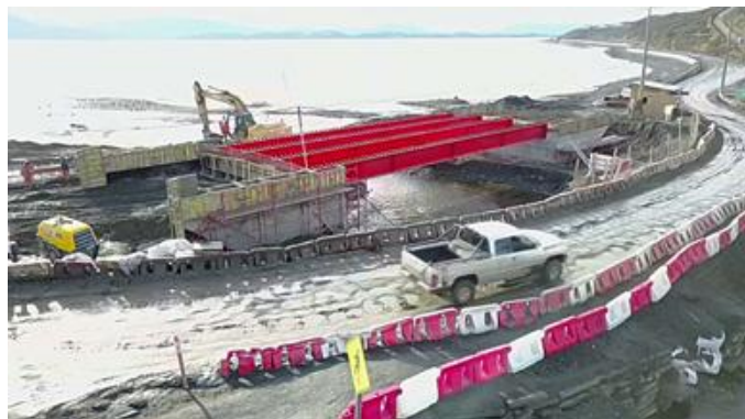
Foto 8: Nuevo puente Ukika con sus vigas colocadas y estribos terminados. (2017)
