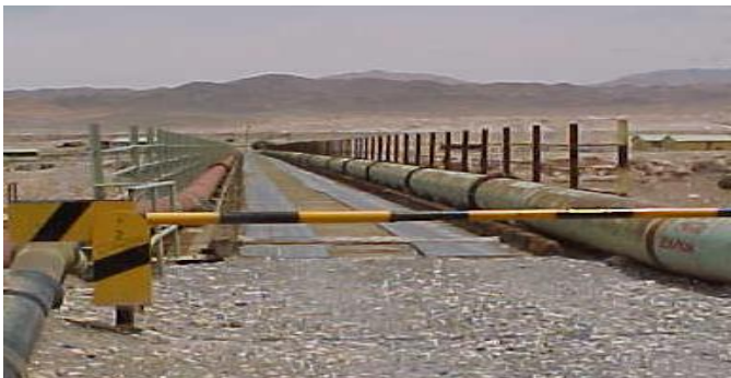
Puente Conchi hoy convertido en acueducto soporta dos grandes tuberías de agua
