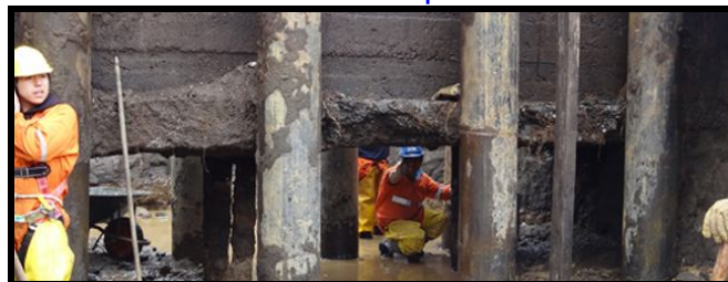
Refuerzo de estribos con pilotes tubulares
